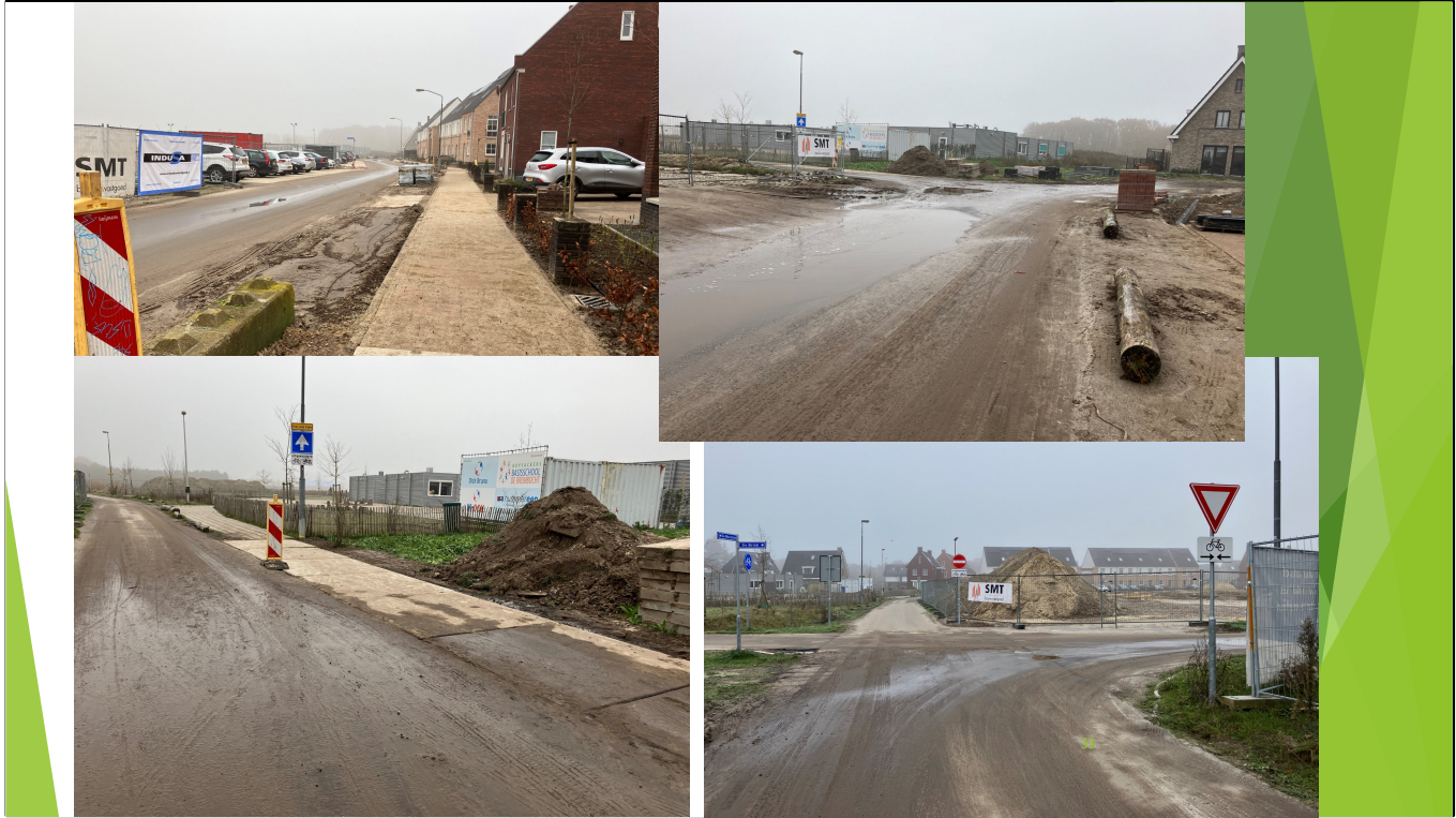
Huidige situatie (begin december 2022). Het voetpad is aangelegd en de eenrichtingsborden zijn geplaatst bij de school.
